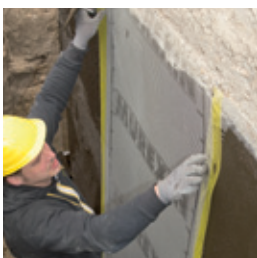
... do ktorej vložíme sklotextilnú tkaninu.
