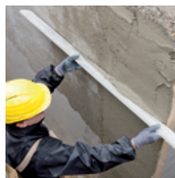
Nanesenú maltu vyrovnáme pomocou laty
