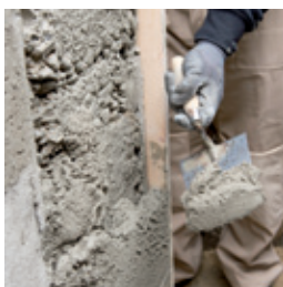
Nerovnosti vyspravíme pomocou sanačných mált Repol .
