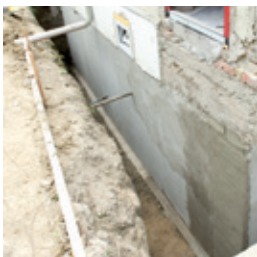
Vyrovnanie podkladu pomocou sanačných mált REPOL .
