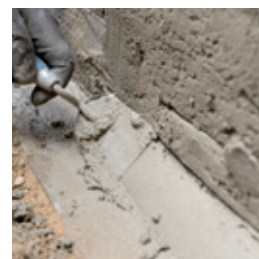
V styku základ / stena zhotovíme fabión zo sanačných mált Repol .
