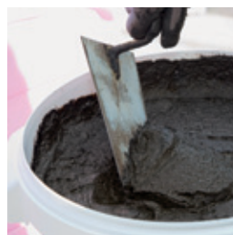
Po vytvrdnutí 2. vrstvy lepíme izolačné dosky.
