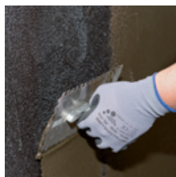
Po vytvrdnutí 1. vrstvy nanášame 2. vrstvu.
